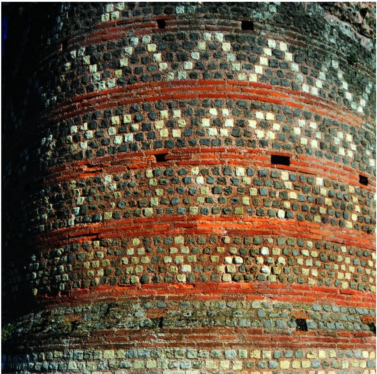
Le mortier rose est composé de brique pilée, associée à du sable et de la chaux.
