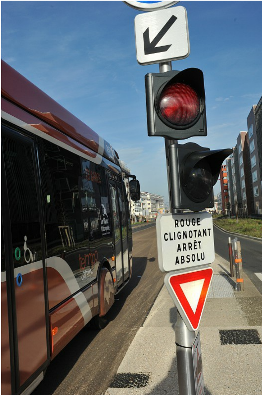
L'installation de la signalisation lumineuse de trafic du bus Tempo, entre Allonnes et Le Mans, a reçu une aide européenne. © Ville du Mans
