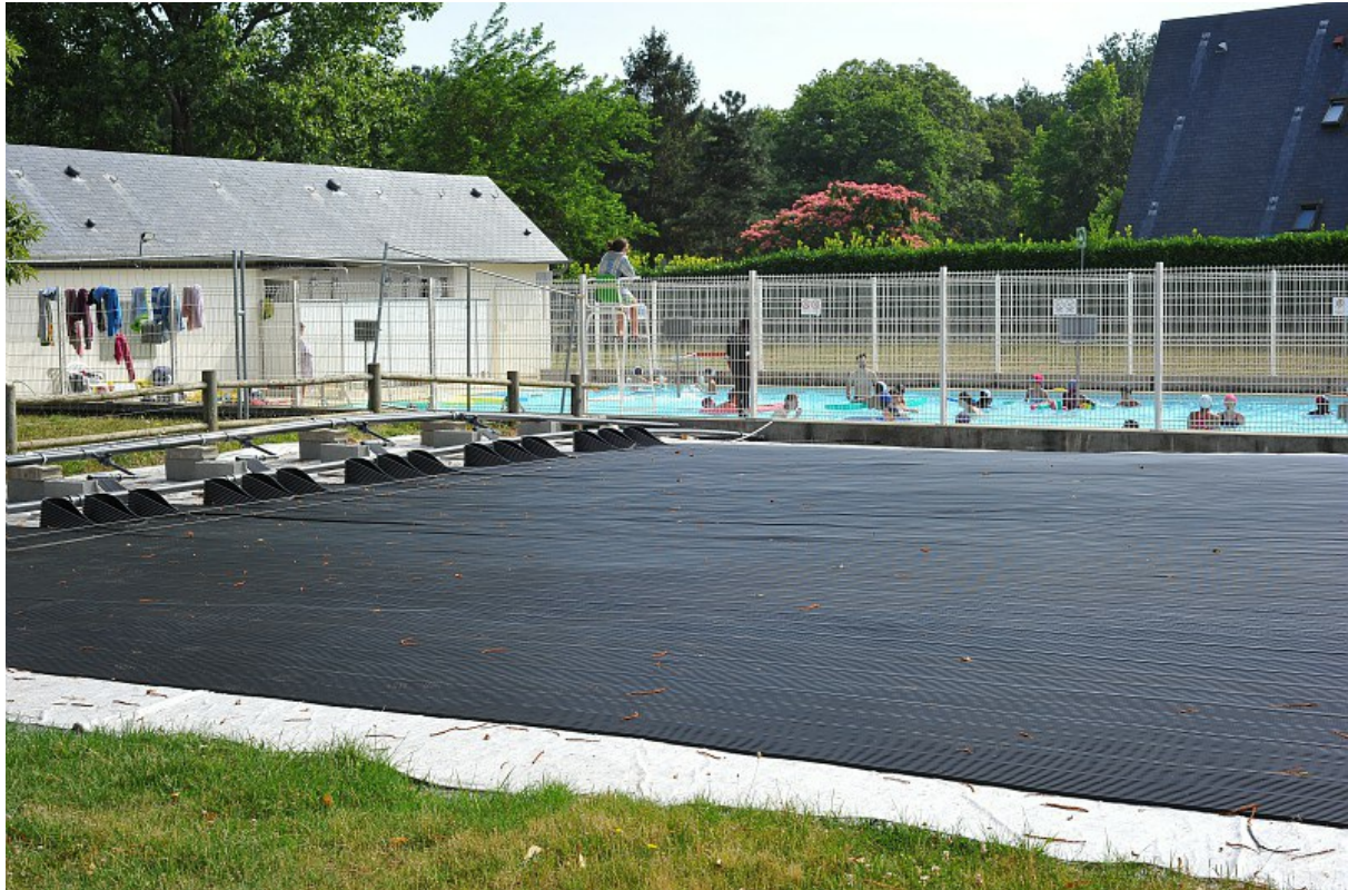
Un tapis solaire thermique chauffe l'eau de la piscine du centre de loisirs des Etangs chauds. © Ville du Mans
