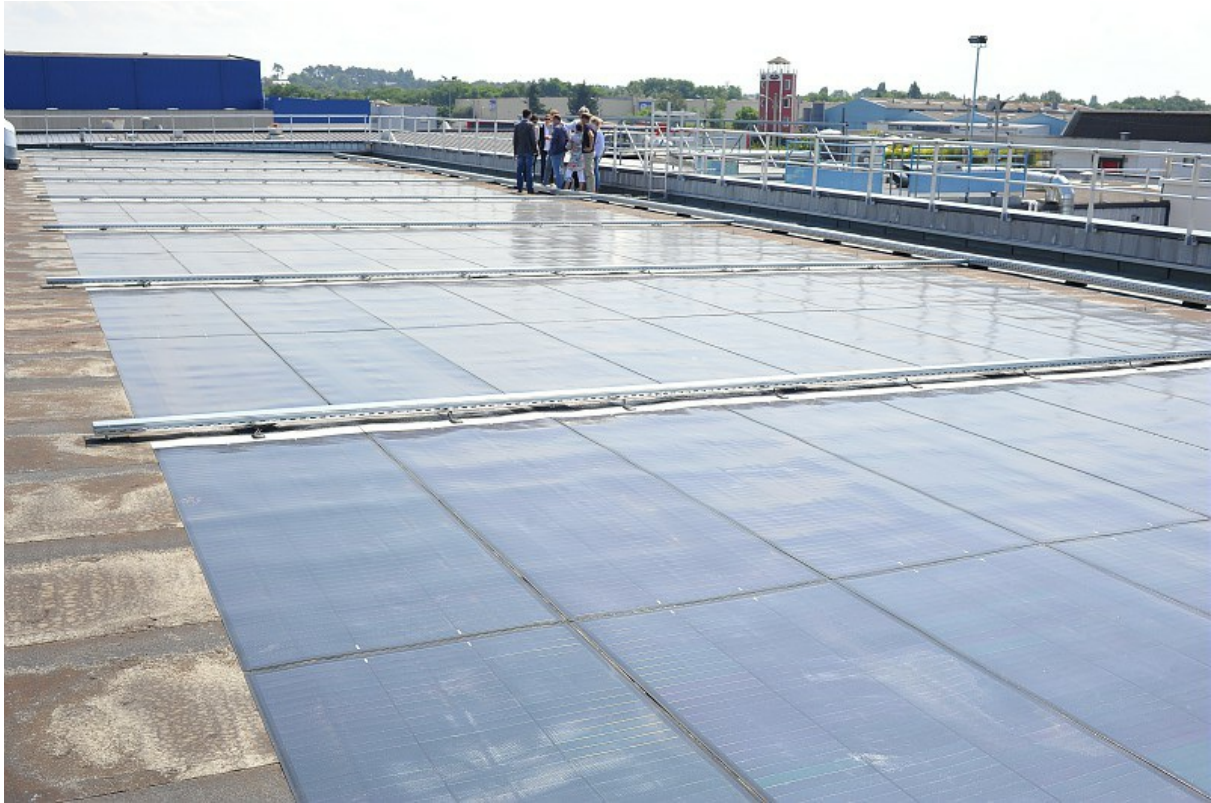
Champ solaire photovoltaïque installé sur le toit de la cuisine centrale. © Ville du Mans
